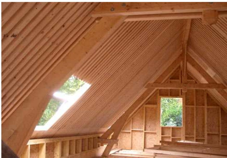
Fig. 3a/3b : Toiture VégA avec ferme traditionnelle supportant une panne faîtière.
